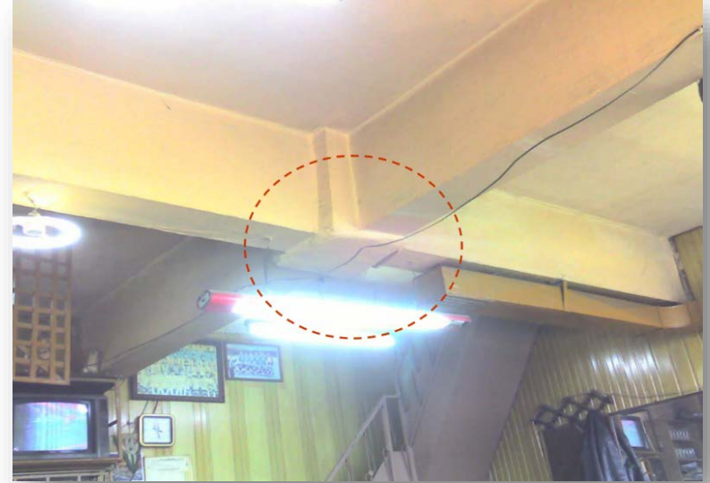
Hacim kazanmak amacıyla kesilip kaldırılmış kolon
