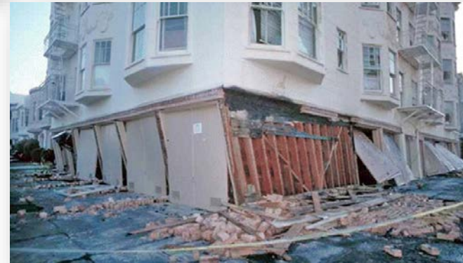
Hacim kazanmak amacıyla kesilip kaldırılmış kolon
